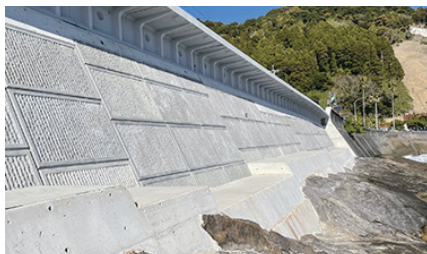
写真-2 宮崎県宮崎市 大型もたれ式擁壁
