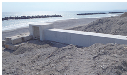
写真-2 高知県南国市 ボックスカルバート
