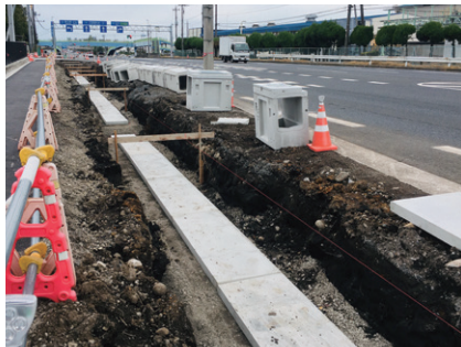
街渠縦断管基礎
