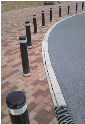
インターロッキング
