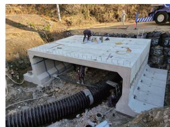
フリースパンカルバート (3分割カルバート)
