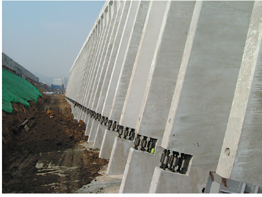
組立式逆T型擁壁 (H=11,000mm)
