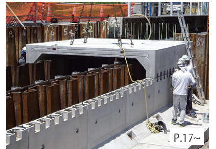
フリースパンカルバート 3分割カルバート
