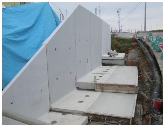
施工状況（底版部現場打ち）
