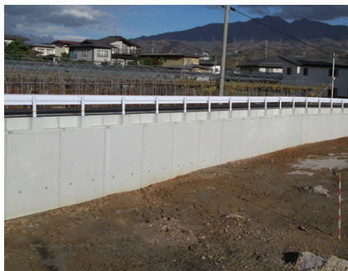
④ 埋め戻して完成
