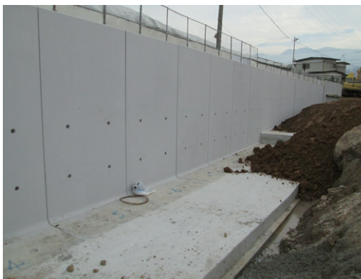
③ コンクリート打設
