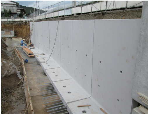
① 製品の据え付け
