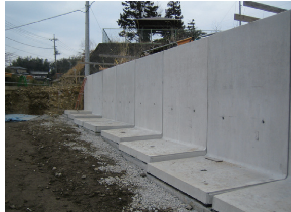
【KGL】 敷き段差施工
