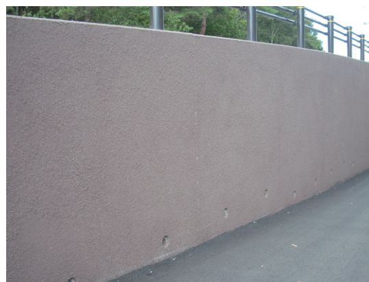
吹き付け塗装
