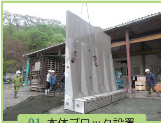
01 本体ブロック設置
