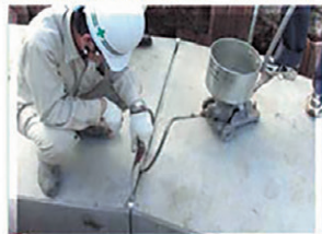
注入口より側壁部・底版部へ注入
