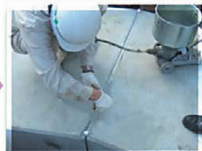
上部より頂版天端部へ注入
