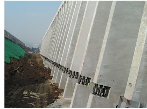
組立式逆T型擁壁 (H=11,000mm)
