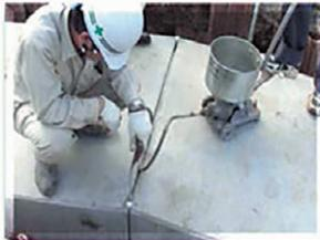
注入口より側壁部・底板部へ注入
