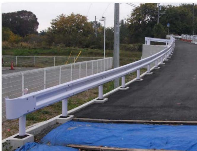
▲アスファルト面を少し下げる事によって、水の流れ落ちをブロックする事も出来ます。
