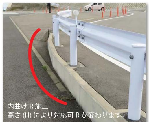
内曲げ R 施工高さ (H) により対応可 R が変わります。
