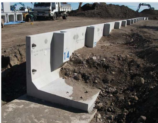
▲ガードレールを設置する基礎がすでにあるので、埋め戻すだけの簡単施工！
