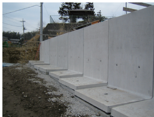
敷き段差施工
