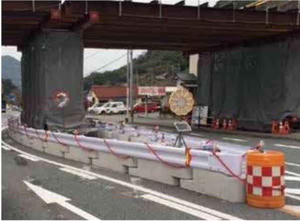
自在R連続基礎は一般道における歩行者安全対策や、高速道路の車線規制、工事作業帯の安全確保など、様々な現場の安全を確保することが可能です。置き式に使用した基礎を別の現場へ転用、埋設基礎へ転用することも容易です。
