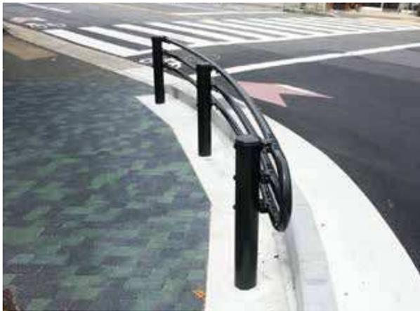
防護柵は「防護柵の設置基準・同解説」及び「車両用防護柵標準仕様・同解説」に基づき安全を照査し設置されます。自在R連続基礎は現場状況を考慮し、衝突時の安全を確保できることを照査したうえで使用いただきます。
