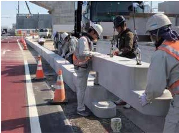
施工方法は、基礎設置→ボルト連結→防護柵設置の簡単3ステップ。即日開放を求められる現場や、夜間工事等の短時間施工を求められる現場においても、容易な施工方法で施工時間を大幅に短縮することが可能です。
