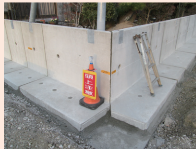
転落防止柵用「支柱固定用ボックス」を使ったKGL
