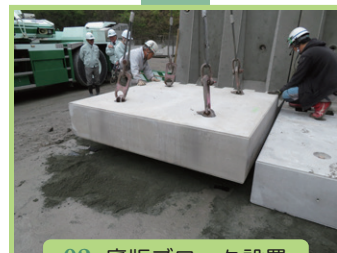
02 底版ブロック設置
