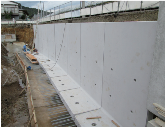
①製品の据え付け
