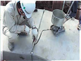
注入口より側壁部・底版部へ注入
