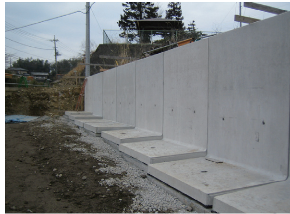
敷き段差施工
