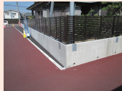
転落防止柵用「支柱固定用ボックス」を使ったKGL
