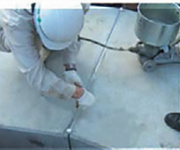
上部より頂版天端部へ注入
