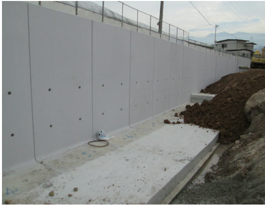
③コンクリート打設
