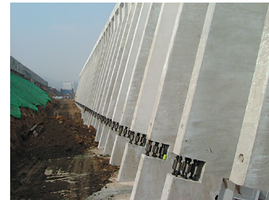
組立式逆T型擁壁 (H=11,000mm)
