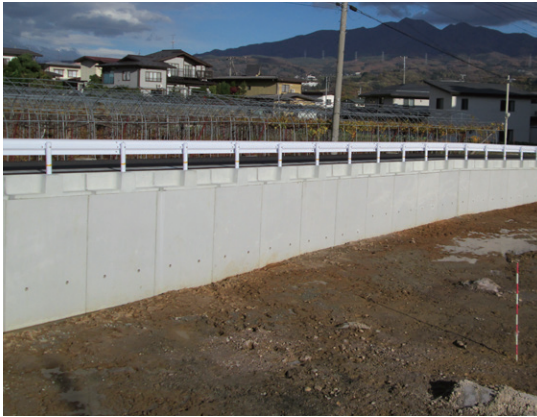
④埋め戻して完成
