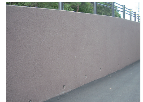
吹き付け塗装
