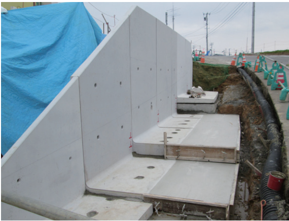
施工状況（底版部現場打ち）
