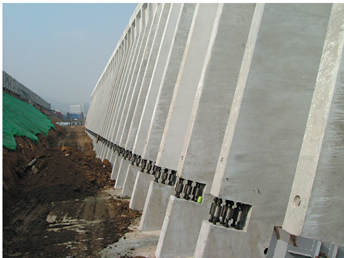
組立式逆T型擁壁(H=11,000mm) ※KTジョイント開口部は、無収縮モルタルを充填します。
