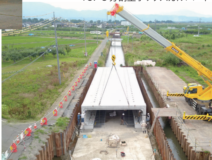
<底版現場打ち併用タイプ> TCV-3分割型ボックスカルバート
