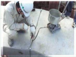
注入口より側壁部・底版部へ注入
