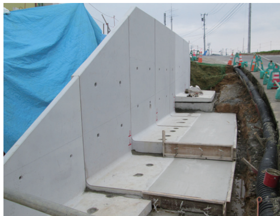
施工状況（底版部現場打ち）
