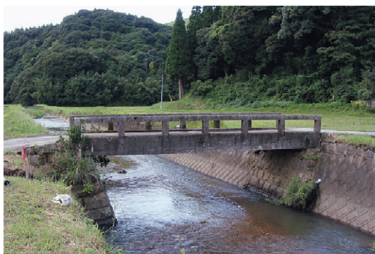
改修前既設橋
