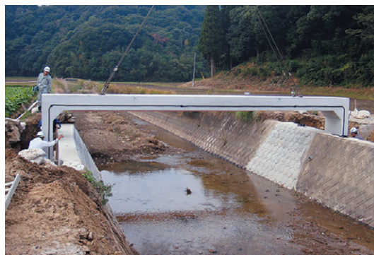
改修後新設橋
