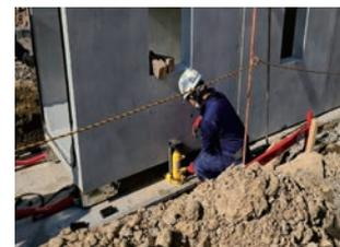
所定の位置まで移動したら、爪付きジャッキでジャッキアップし、電動ローラーを回収します。
