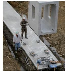
配置した電動ローラー上に、クレーンで製品を吊り下します。
